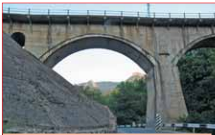
Мост железнодорожной ветки Белореченск-Туапсе, вид по направлению движения от Туапсе
